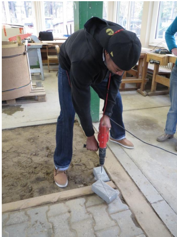
Löcher in Betonpflastersteine bohren
