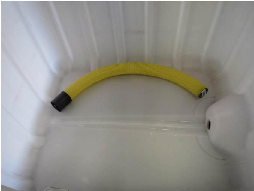
Drainagerohr DN 80 mit Endkappe und Übergangsstück auf DN 50
