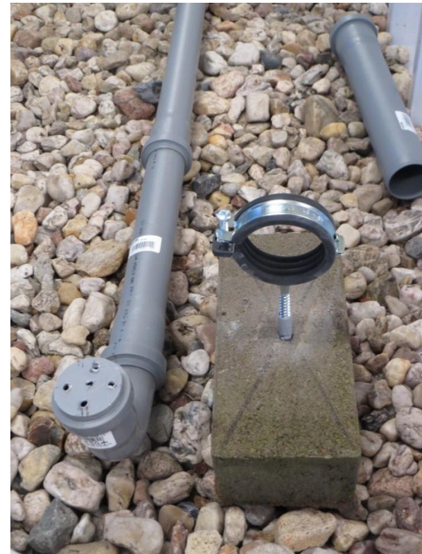
Rohr mit Gelenkrohrschelle am Stein befestigen
