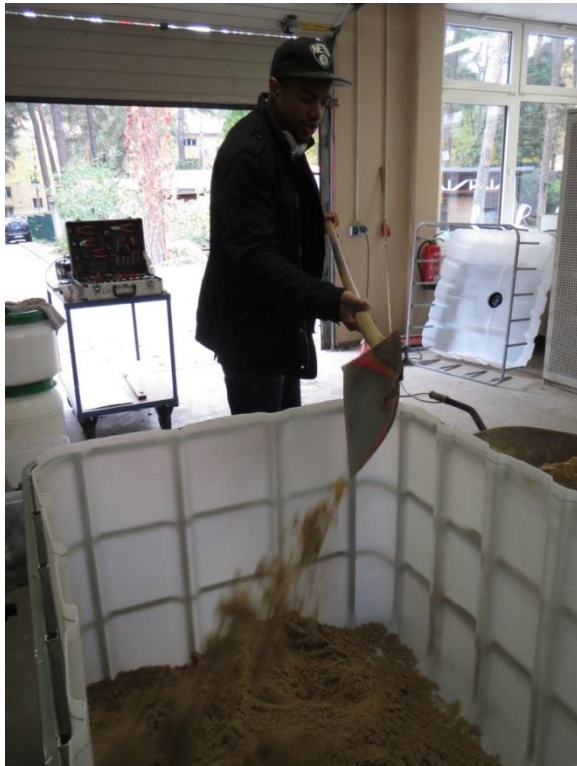
Behälter ca. 50 cm hoch mit Sand auffüllen (500 l)
