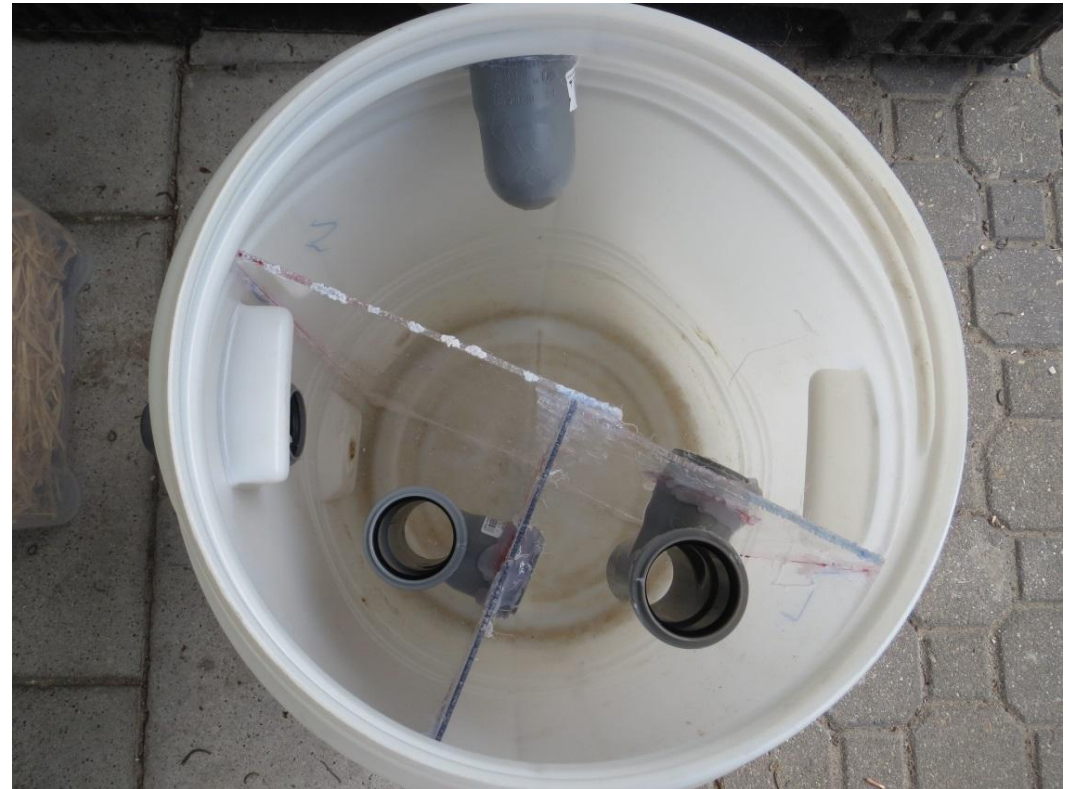
Dreikammergrube mit Zulauf, höhenversetzten Überläufen und Ablauf
